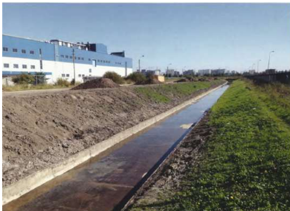
Рисунок 5.1 – Мелиоративный канал в железобетонной облицовке
