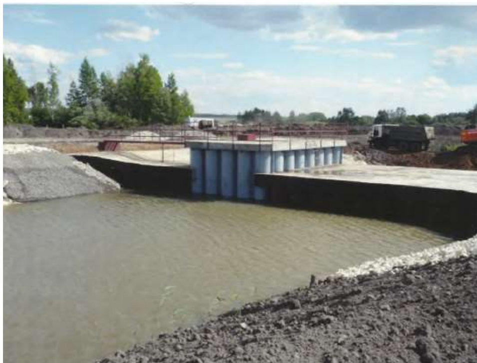
Рисунок 5.5 – Строительство переливной плотины из трубошпунтовых сварных свай
